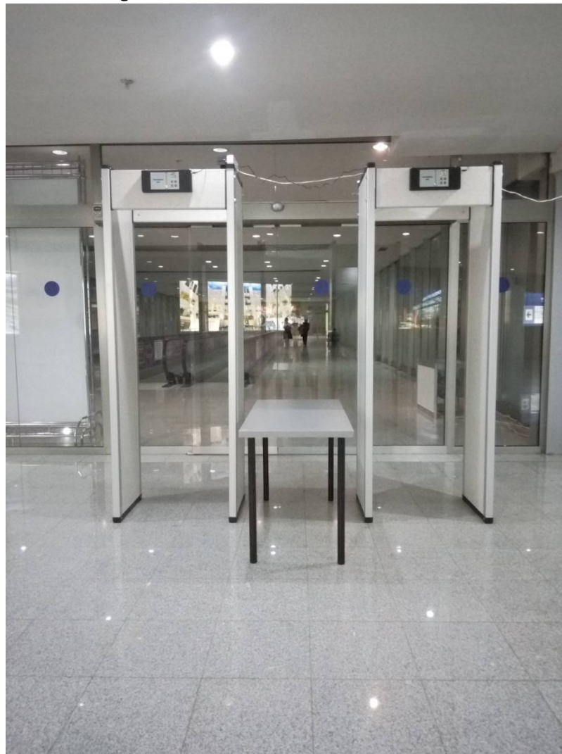
«Гвоздика-006» при входе в галерею «Крокус Сити Холл»
